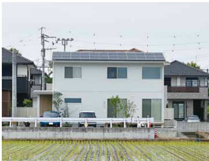
△ 太陽光パネル設置完了
