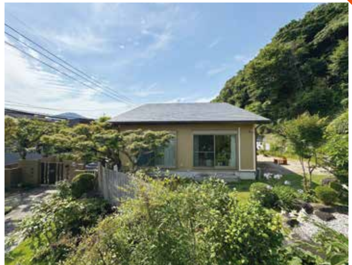
△ 外装塗装／屋根塗装完了
