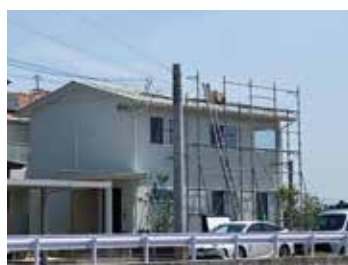
△ 足場を組んでパネルの運搬
