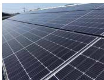
△ 太陽光パネル設置完了
