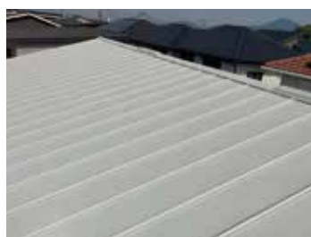
△ 施工前の屋根
