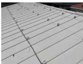
△ 太陽光パネルの架台設置
