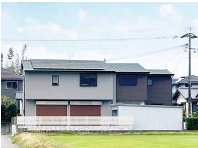
△ 太陽光パネル設置完了
