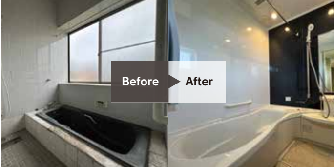
浴室 | 保温機能や窓からの冷気などヒートショック対策が不十分な浴室を室内空間との温度差を無くしヒートショック対策された新しいバスルームへ
